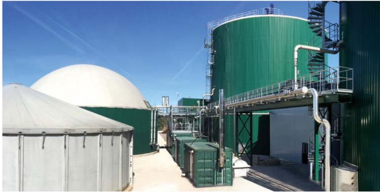
Figur 1. BroGas anläggning lokaliserad i Bro cirka 8 km från Visby.
